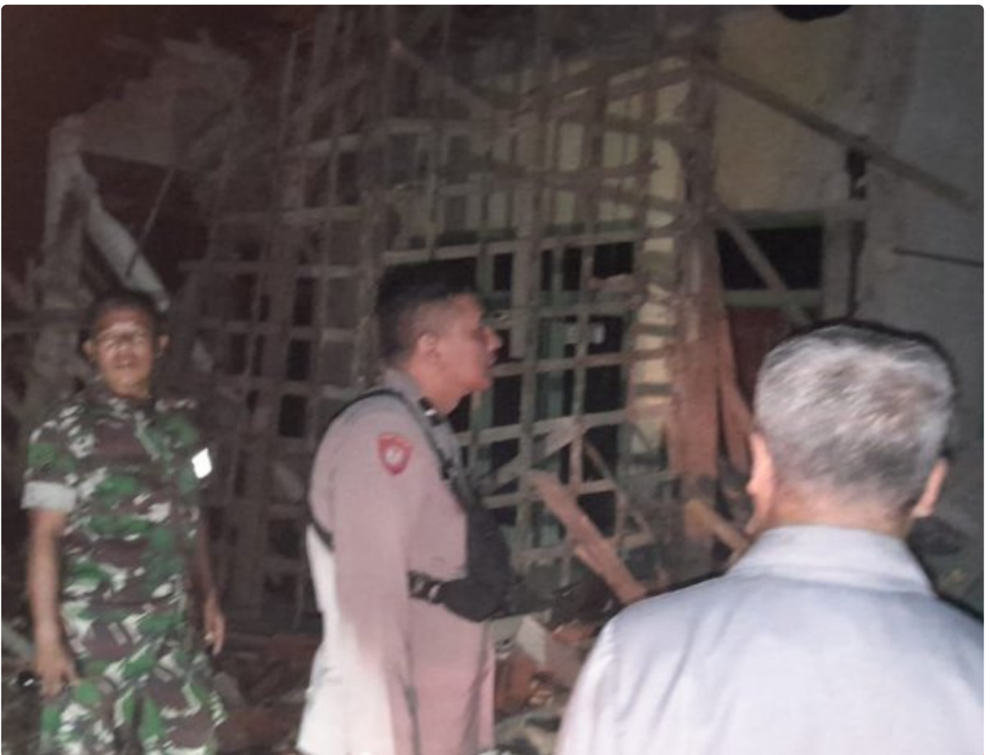
Bangunan Rumah Ambruk di Wilayah Hukum Polsek Surade Polres Sukabumi Desa Cidahu Akibat Gempa, Tidak Ada Korban Jiwa
